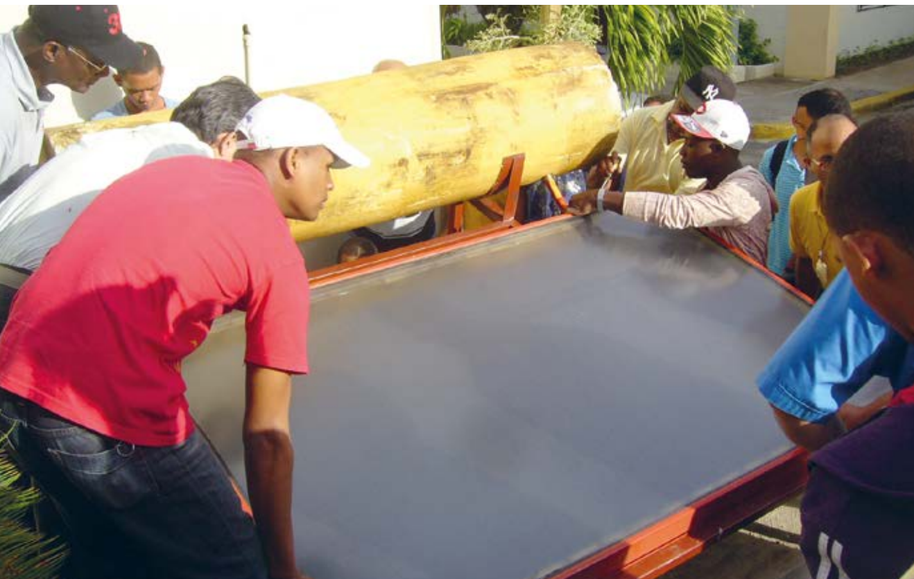
Einbau von Solaranlagen in einem Hotel, Dominikanische Republik
