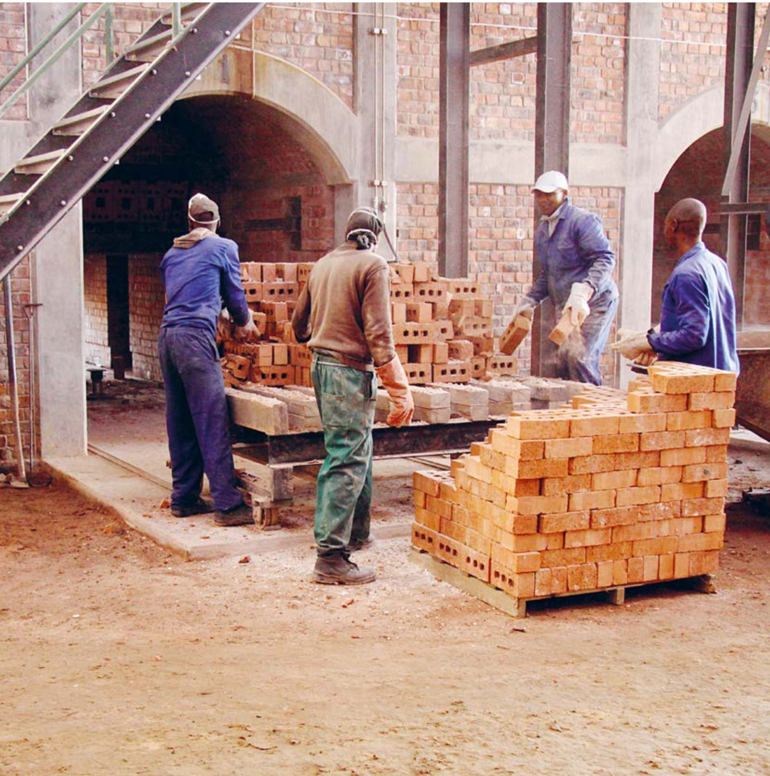
Energieeffiziente Backsteinproduktion in Jeffreys Bay, Südafrika
