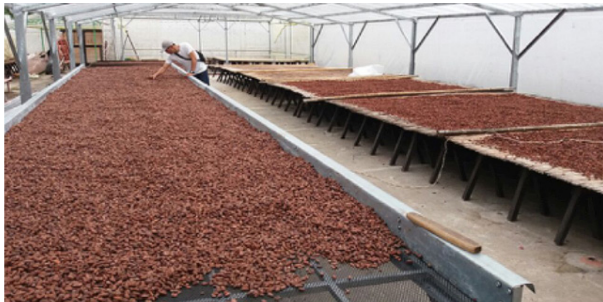
Ilustración 51. Invernaderos y mesones en metal con mallas plásticas (izquierda) y cubierta de tejas de policarbonato.
