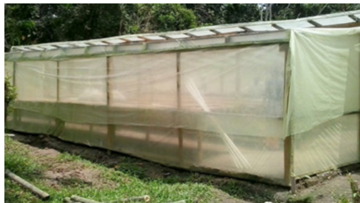
Ilustración 42. Drenaje perimetral de invernadero
