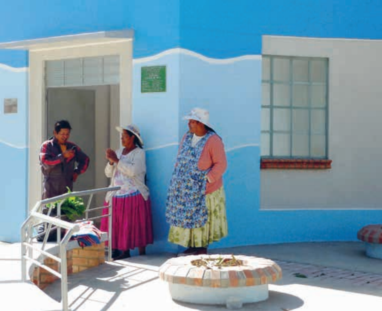
Kiosque de distribution d'eau potable à Achocalla, Bolivie
