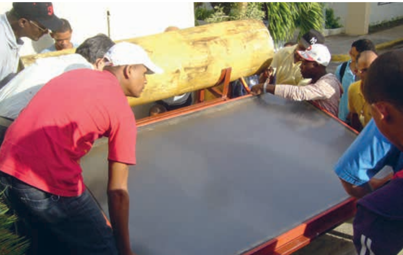
Montage d'installations photovoltaïques dans un hôtel, République dominicaine
