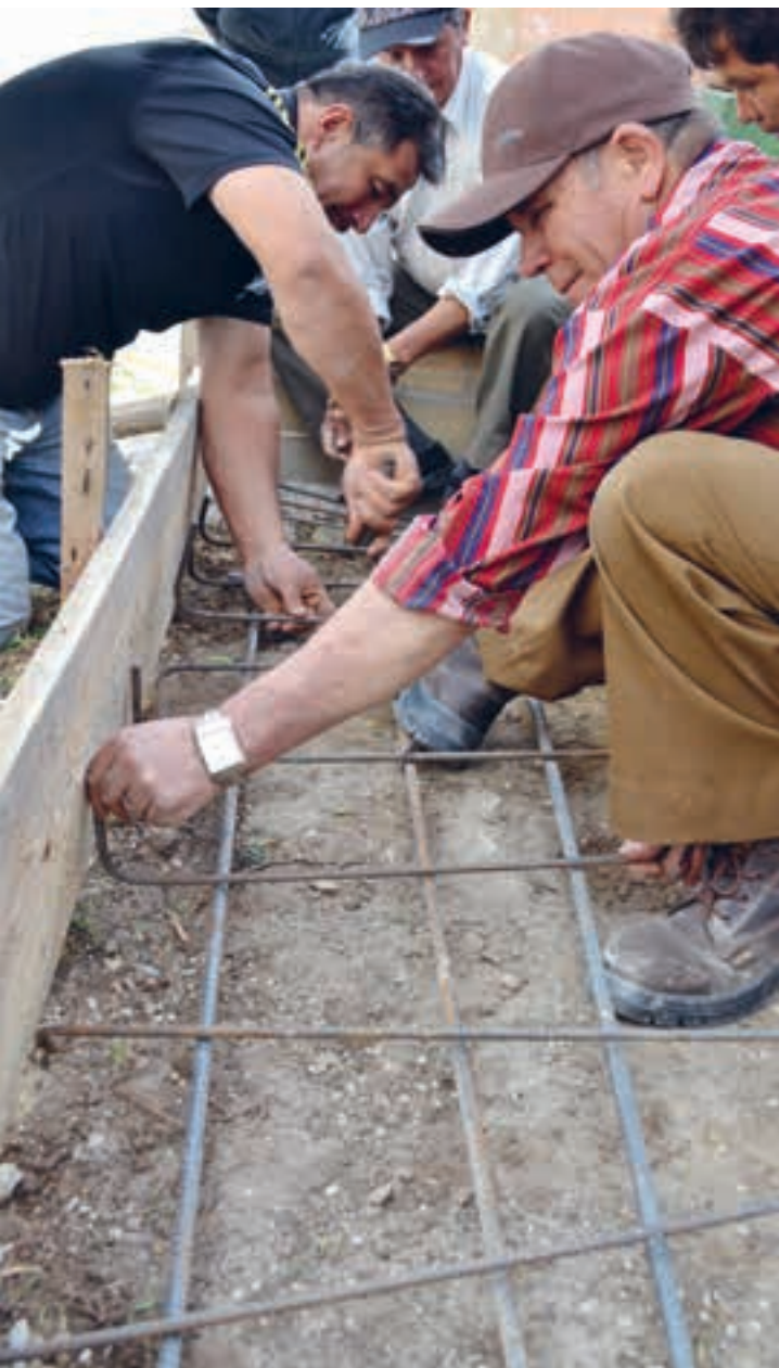
Formation d'ouvriers de la construction à Bogota, Colombie
